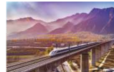
为西成高铁提供高铁聚氨酯
